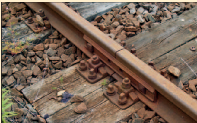
Bild 2 Bestandteile des Oberbaus
